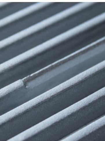
Für die Reparatur
